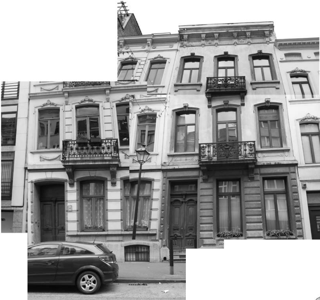
rue Berckmansstraat 110, 112, 1870-1871 arch. G. De Man
